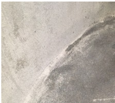
Grundierte Wandfläche, mit Quarzsand abgestreut
